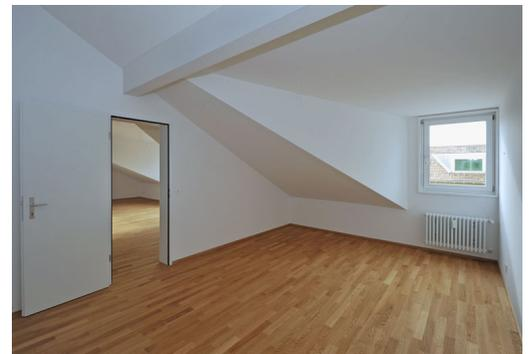
Die schrägen Seiten der Gauben öffnen den Raum und ermöglichen eine grössere nutzbare Fläche
