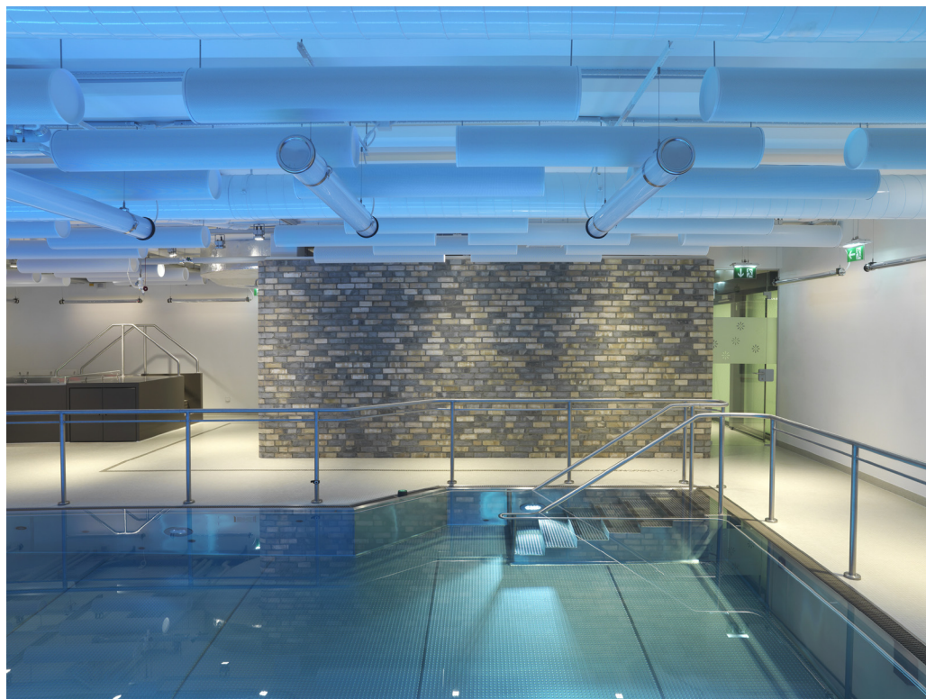
Hallenbad nach der Sanierung
